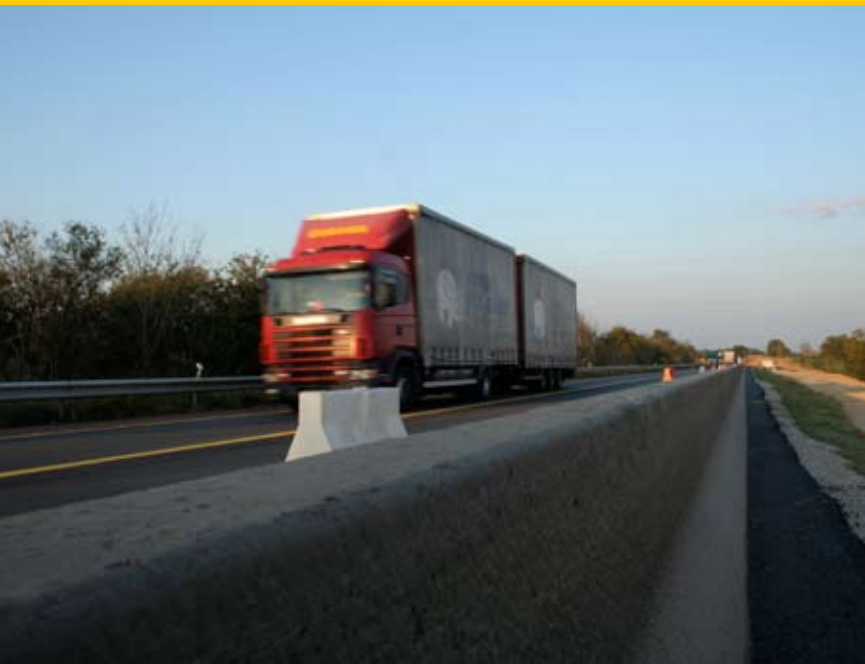
Une glissière béton est réalisée grâce à l'utilisation d'une machine à extruder (ci-dessous).
