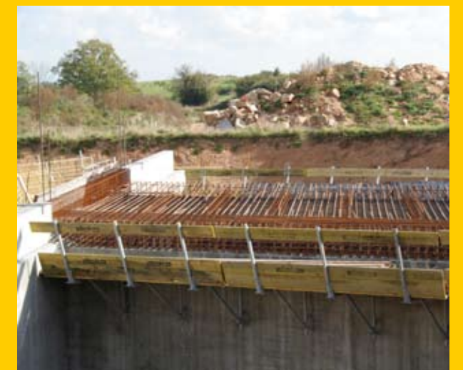
Le tablier est ferrailé avant que le béton ne soit coulé.
