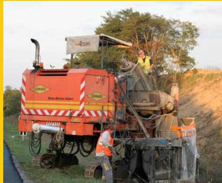
Une glissière béton est réalisée grâce à l'utilisation d'une machine à extruder (ci-dessous).
