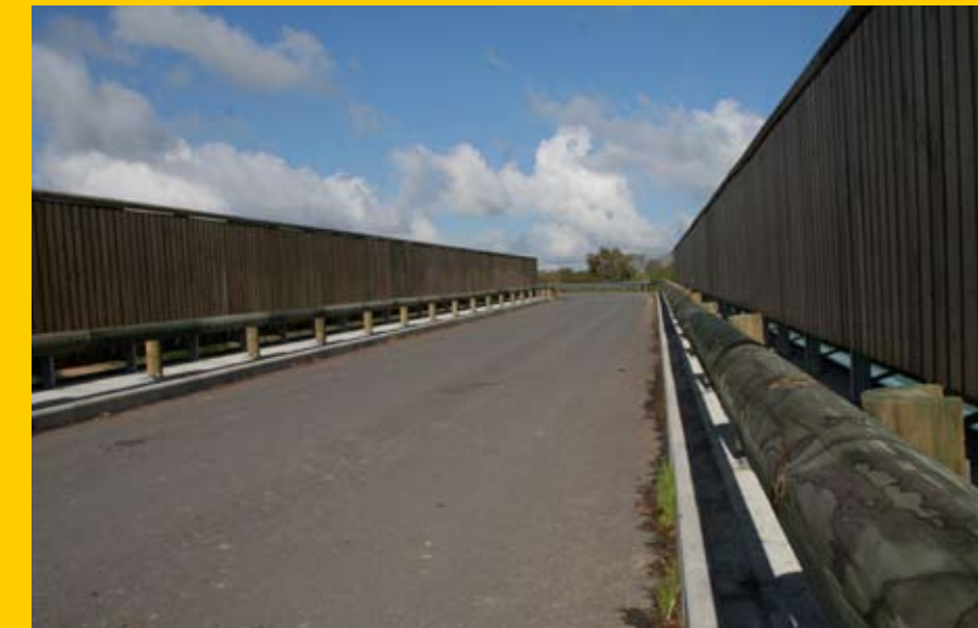
Un passage à faune privilégie le bois au béton.
